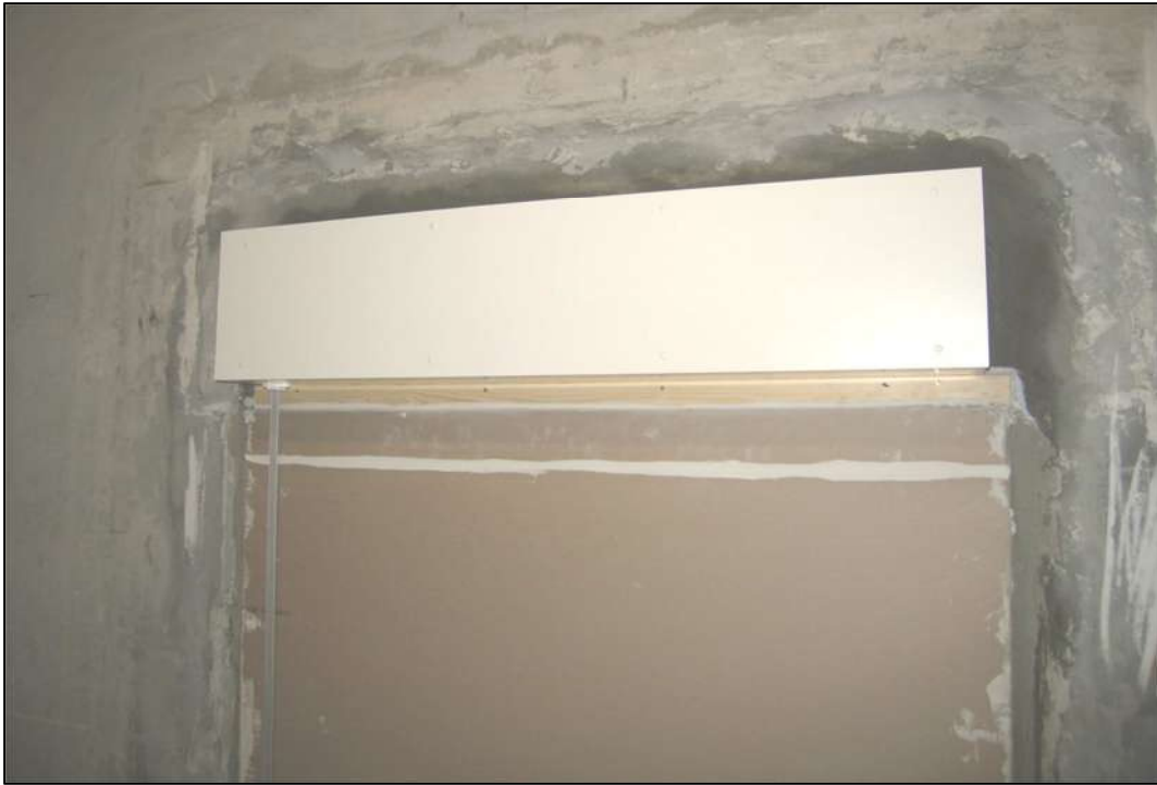
Fotografia dell'oggetto in una delle configurazioni esaminate
