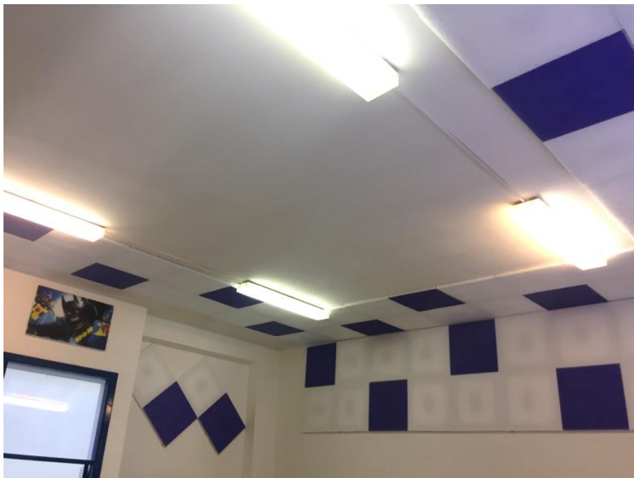
Fig. 22 Particolare dell'aula al primo piano dell'IC di Pellezzano - Plesso Scuola Primaria sito in via della Quercia a Capezzano (Pellezzano – SA) a valle dell'intervento
