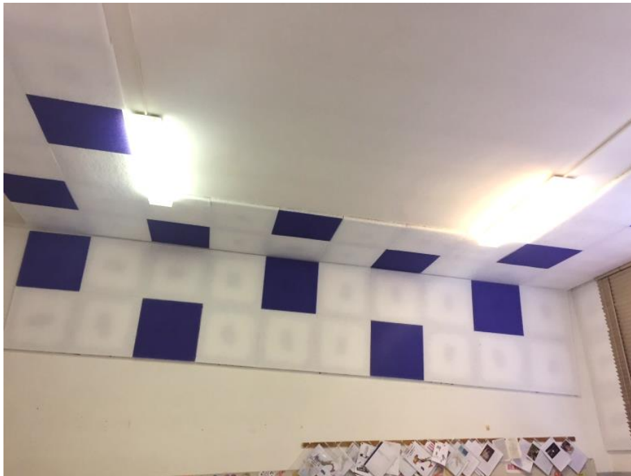
Fig. 18 Particolare dell'aula al primo piano dell'IC di Pellezzano - Plesso Scuola Primaria sito in via della Quercia a Capezzano (Pellezzano – SA) a valle dell'intervento
